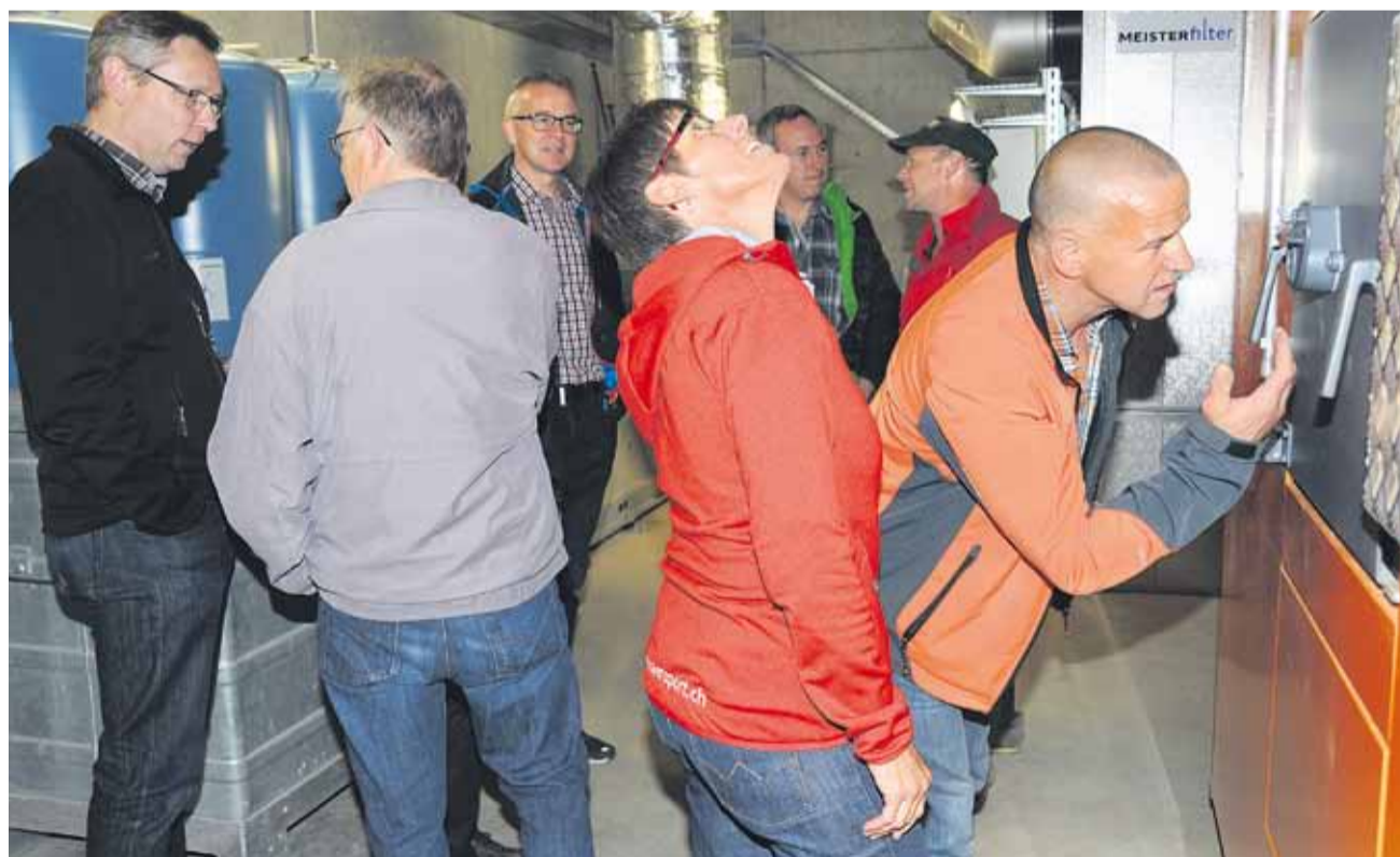
Genau hinsehen: Besucherinnen und Besucher am Tag der offenen Tür in der Heizzentrale des Willisauer Wärmeverbunds. Foto Klaus Marti
